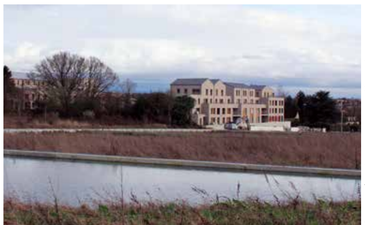
© SORGEM / Mandataire MOE espaces publics : Atelier Marniquet Aubouin / construction Livinx / MOE Septembre et DND architectes
